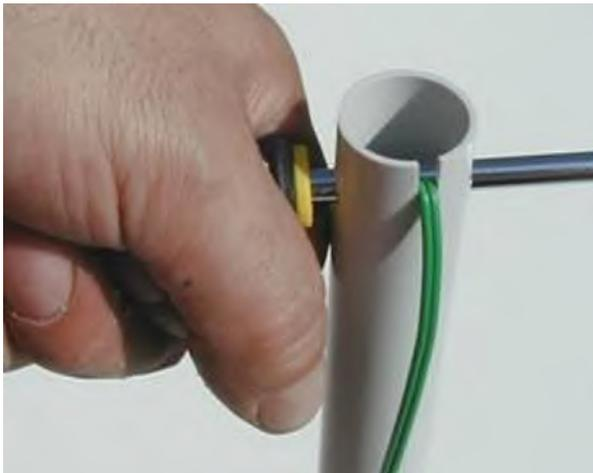
Déposer les sondes profondes percées, à l'aide d'un tournevis **sans jamais tourner ni forcer**.
